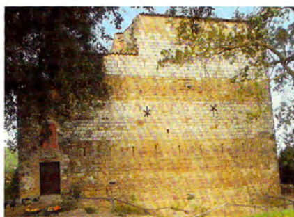
Fig. 3. Vista del parament oriental de la torre.
